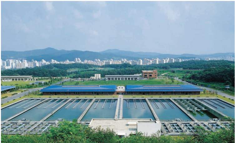
성남 정수장의 전경. © 한국수자원공사
