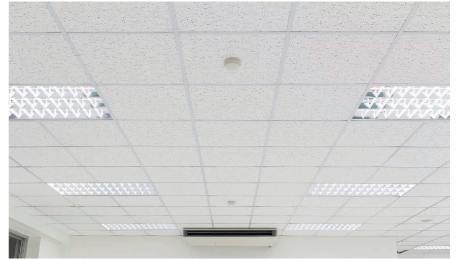
대표적인 준불연재인 석고보드는 불에 강하고 유독가스를 적게 배출하기 때문에 건축자재로 많이 사용한다. © shutterstock.com
